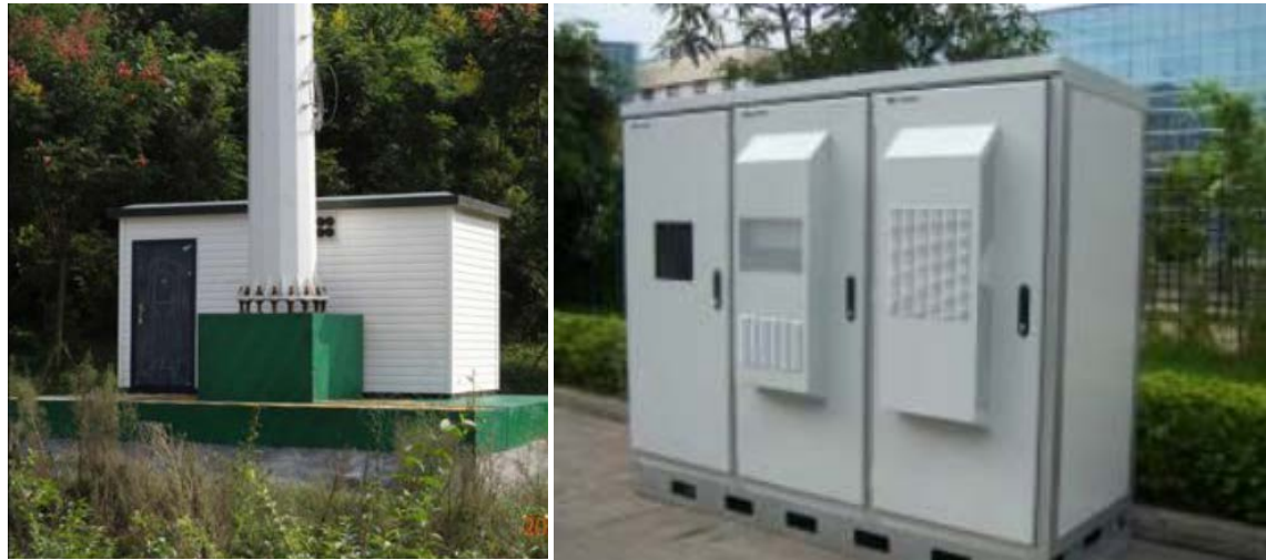
图 7-15 一体化机房图 7-16 室外机柜
