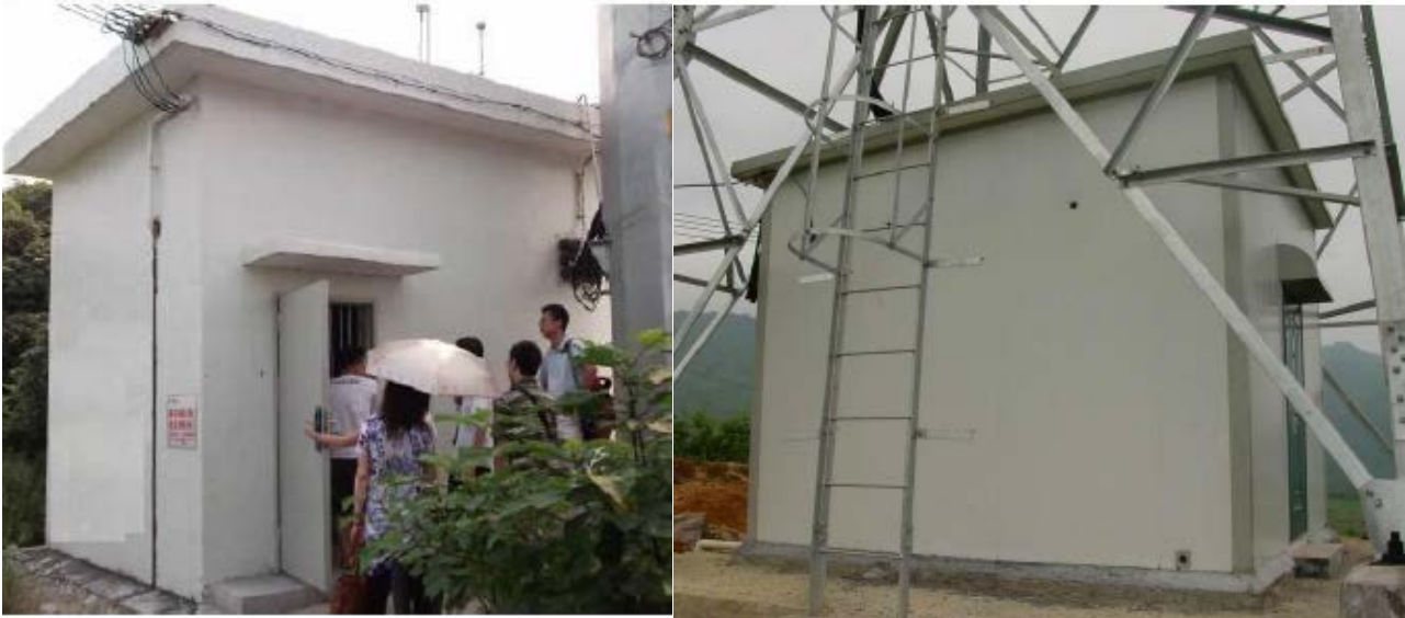
图 7-13 砖混机房图 7-14 彩钢机房
