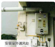
安装室外通风处
