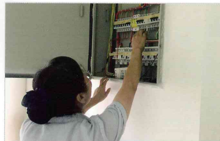
① 发现燃气泄漏禁止开关电器
